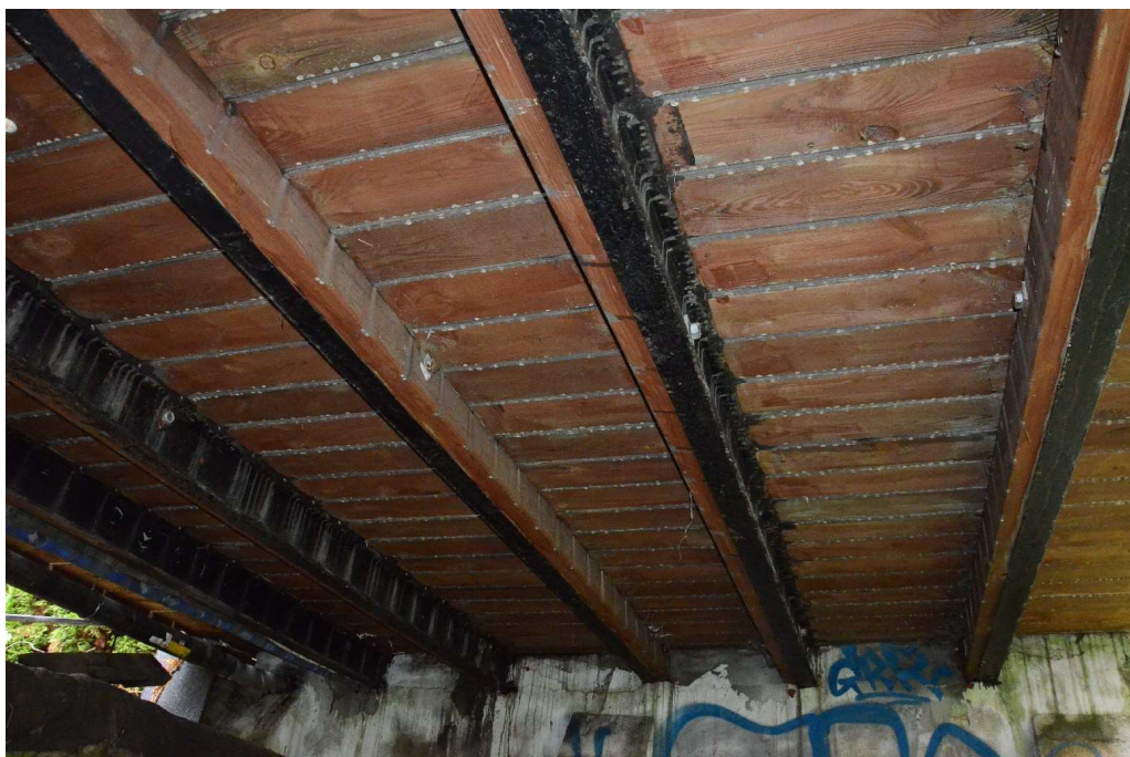
Fot. 3 Widok na spód ustroju nośnego
