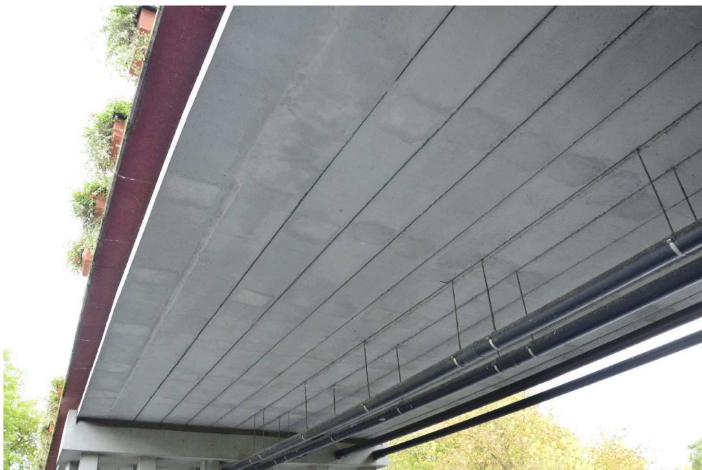
Fot. 3 Widok na spód ustroju nośnego
