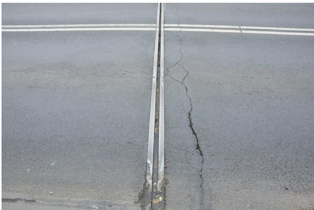
Fot. 3 Nawierzchnia jezdni na dojeździe obiektu
