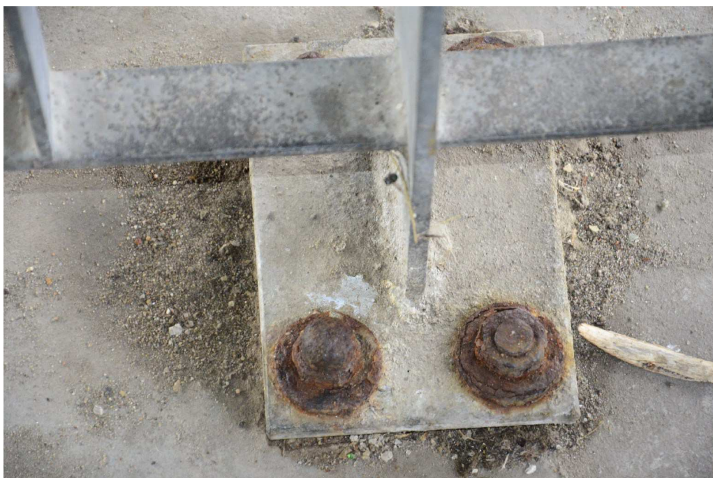
Fot. 13 Balustrada pod obiektem
