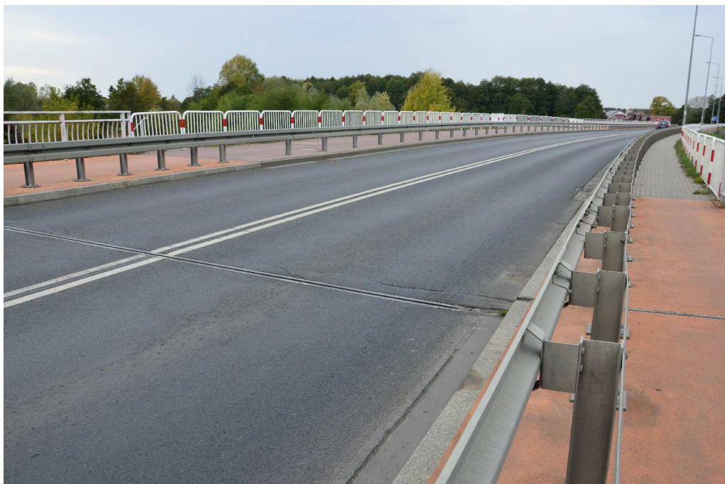
Fot. 2 Widok na jezdnię na obiekcie
