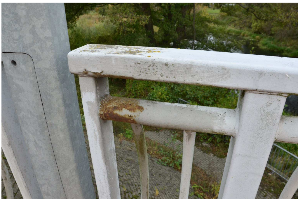
Fot. 9 Balustrada na obiekcie
