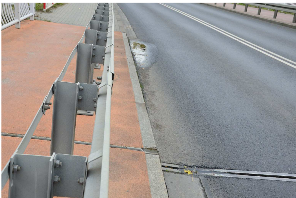
Fot. 4 Nawierzchnia jezdni na dojeździe obiektu
