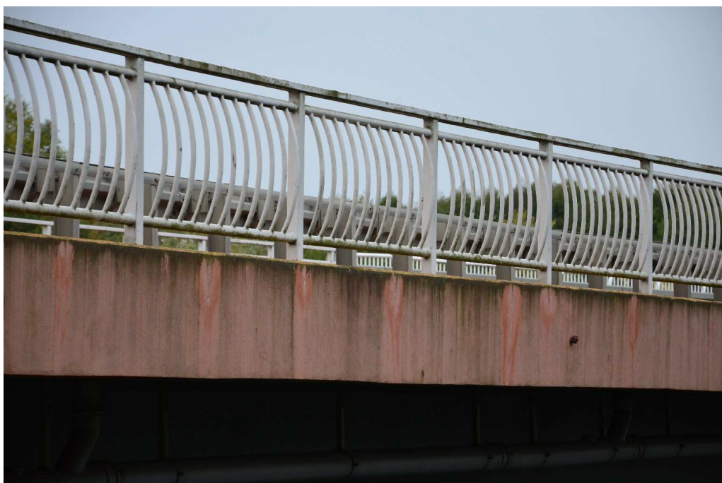
Fot. 11 Belka gzymsowa
