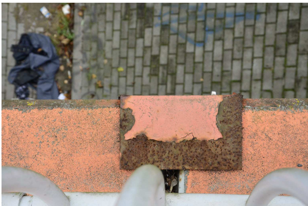
Fot. 8 Modułowe urządzenie dylatacyjne w chodniku
