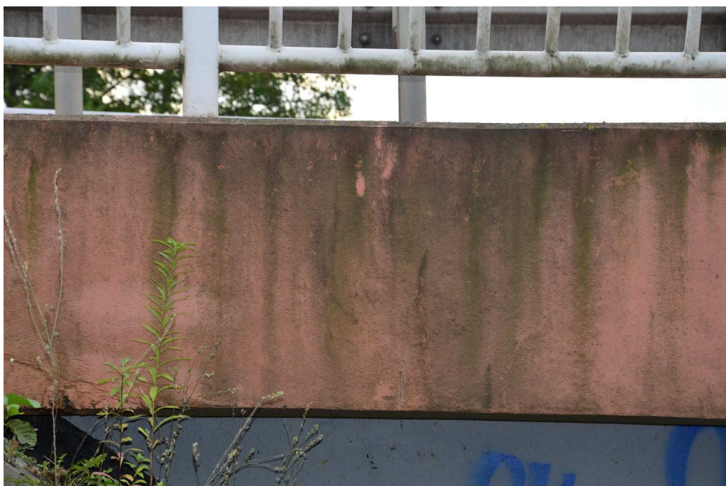
Fot. 10 Belka gzymsowa
