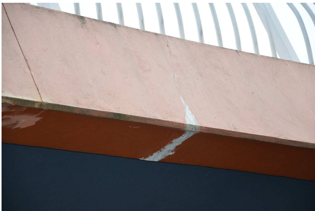
Fot. 12 Belka gzymsowa
