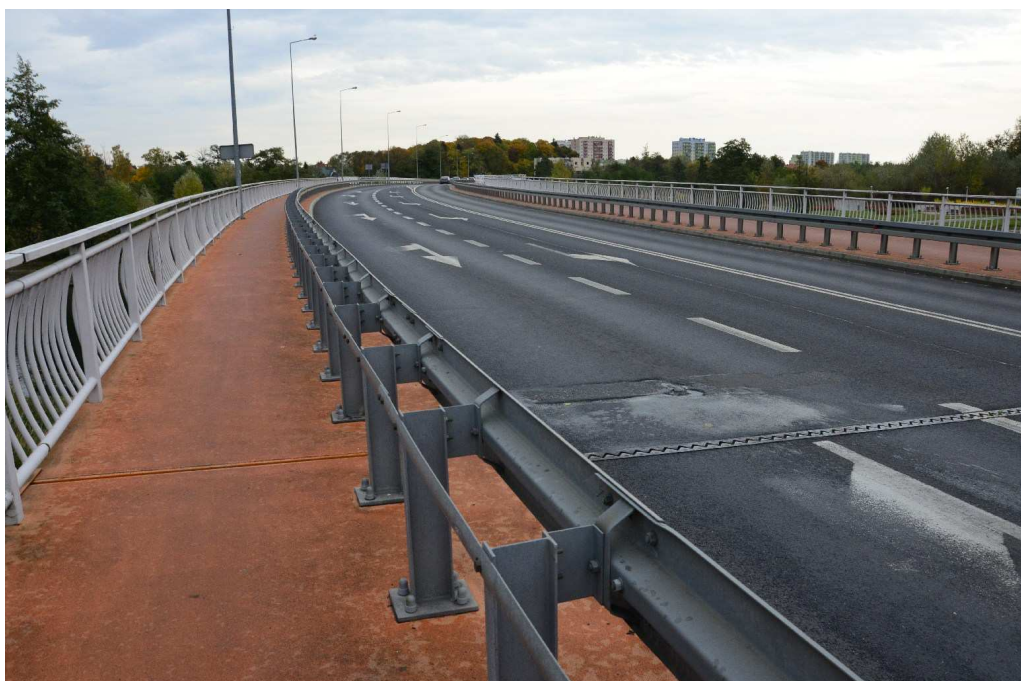
Fot. 2 Widok na jezdnię na obiekcie
