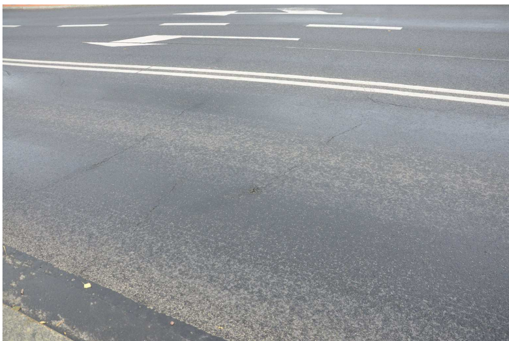
Fot. 3 Nawierzchnia jezdni na obiekcie
