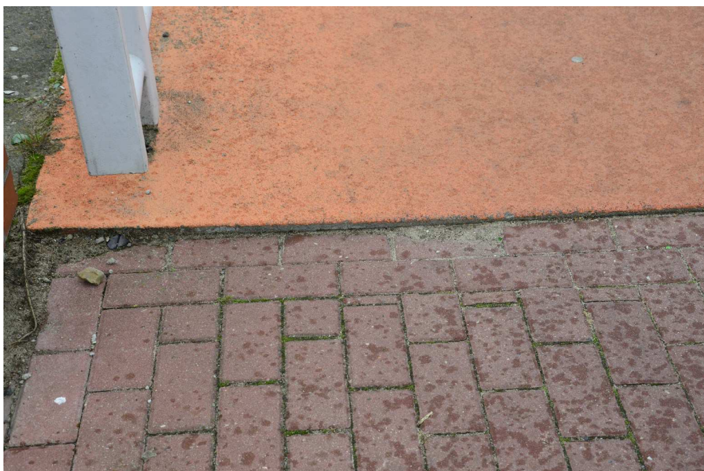
Fot. 11 Nawierzchnia chodnika
