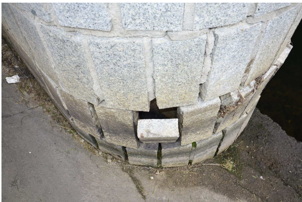
Fot. 14 Filar mostu
