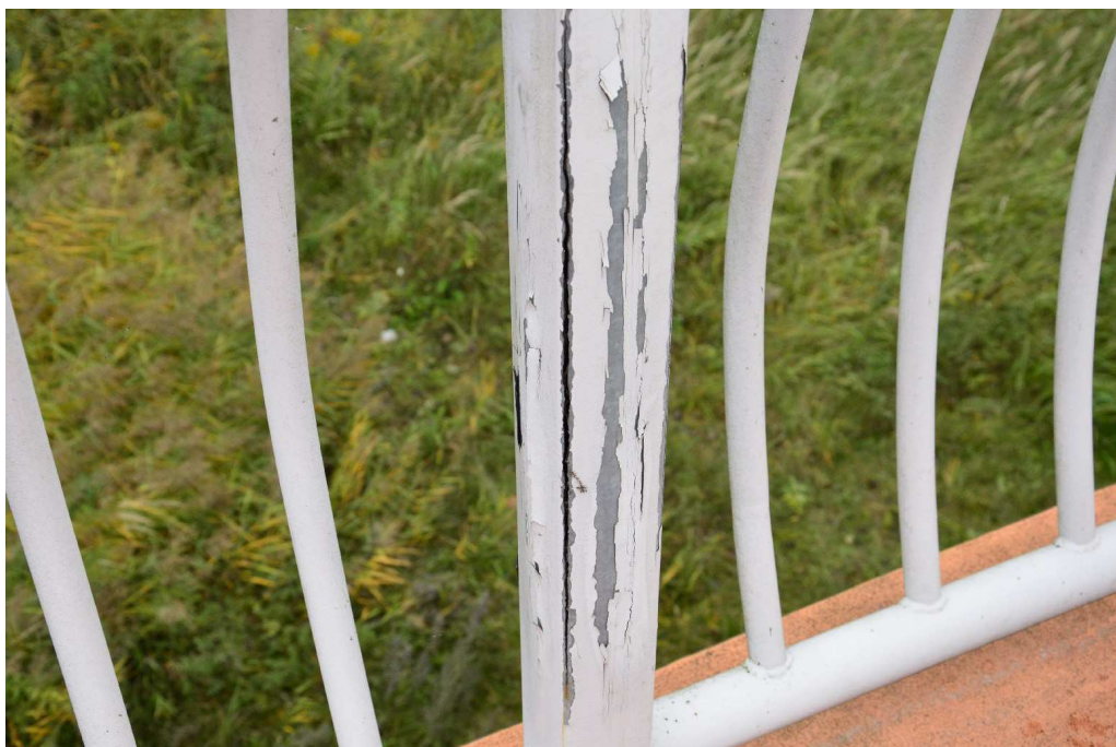
Fot. 10 Balustrada na obiekcie
