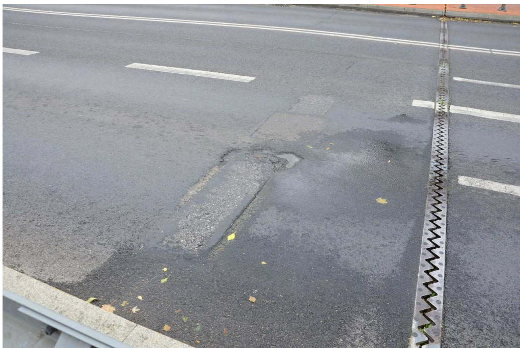
Fot. 4 Nawierzchnia jezdni na obiekcie
