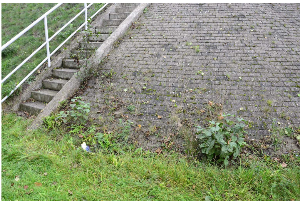
Fot. 17 Skarpa przy obiekcie
