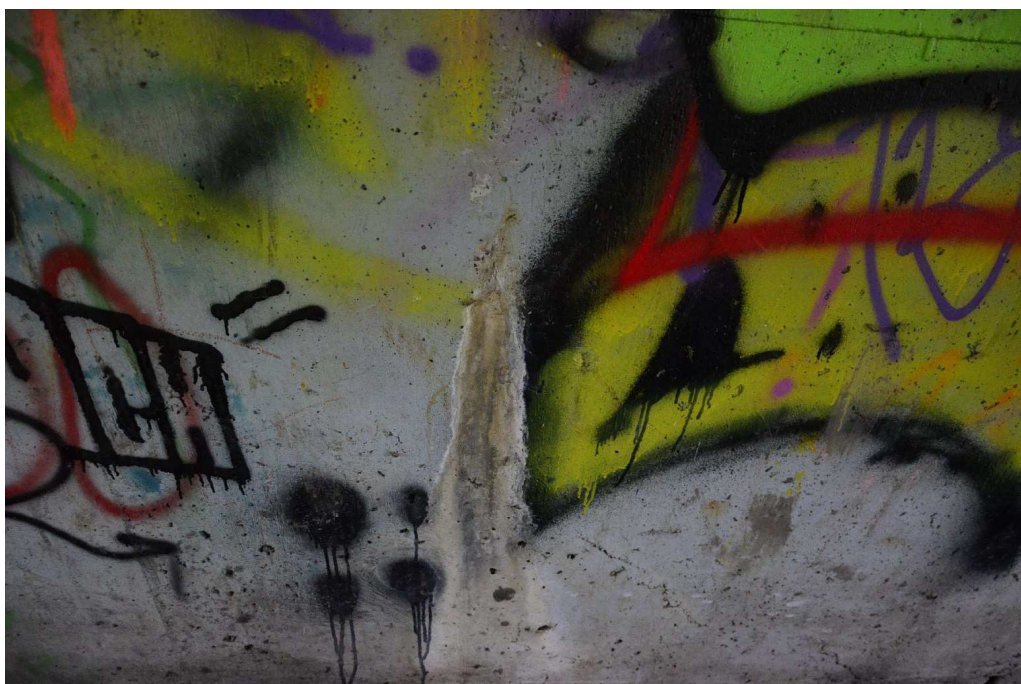
Fot. 16 Przyczółek mostu
