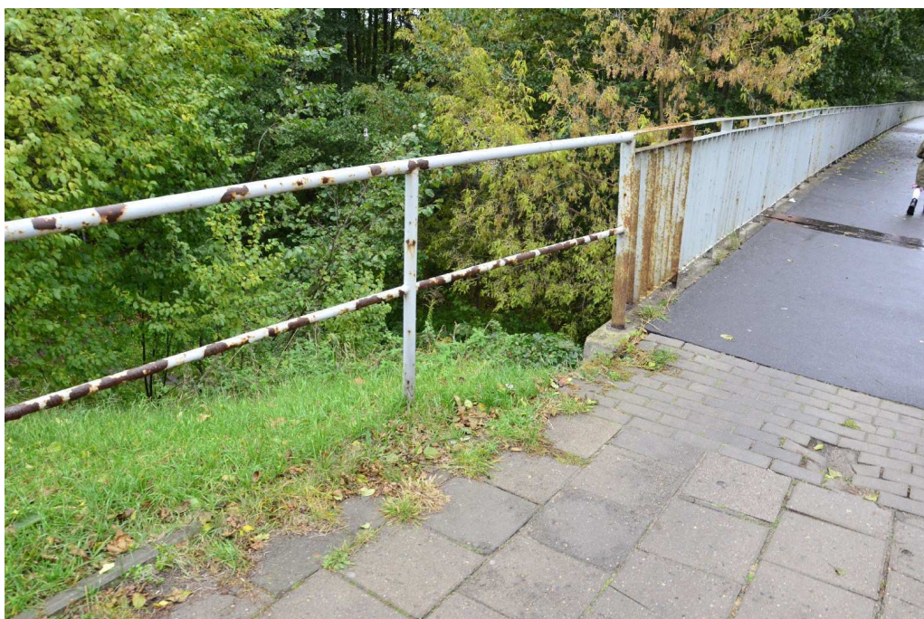
Fot. 10 Balustrada na dojeździe do obiektu
