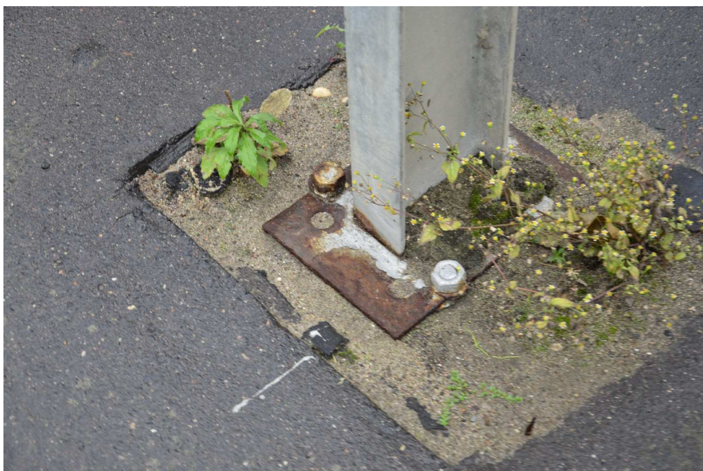
Fot. 9 Bariera na obiekcie
