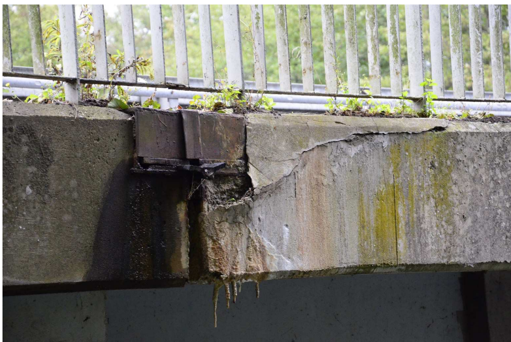
Fot. 13 Belka gzymsowa
