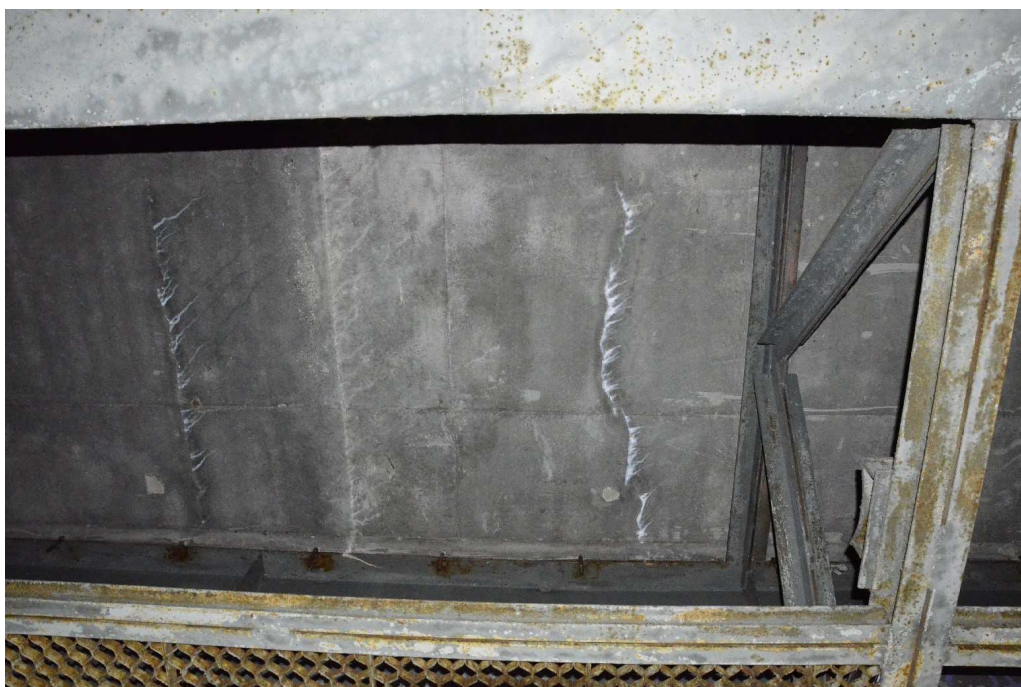
Fot. 14 Płyta pomostowa
