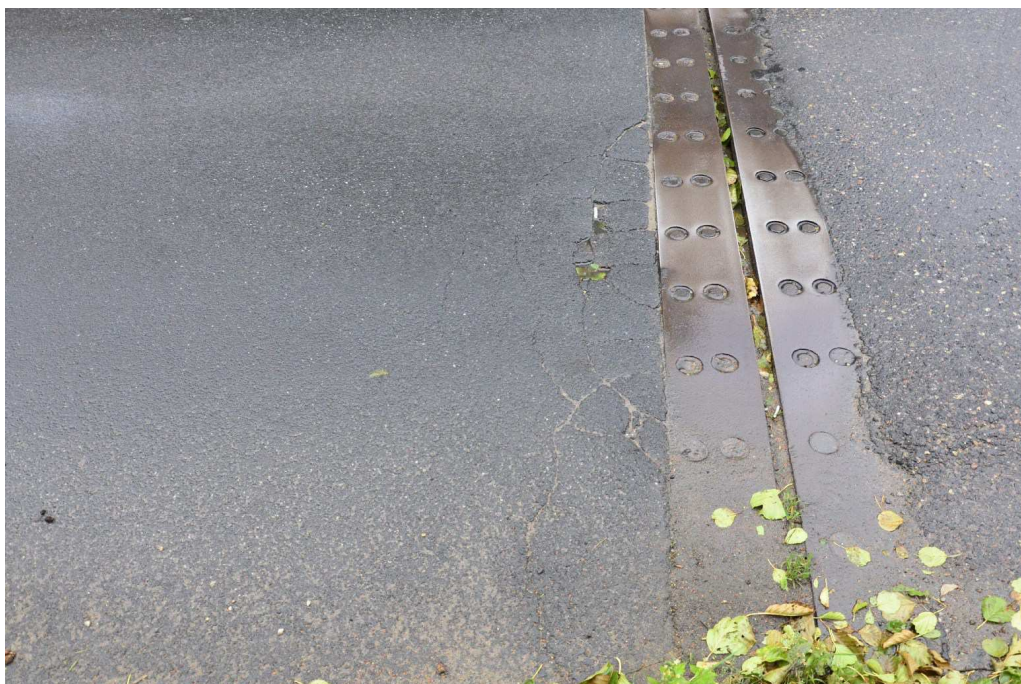
Fot. 4 Urządzenie dylatacyjne
