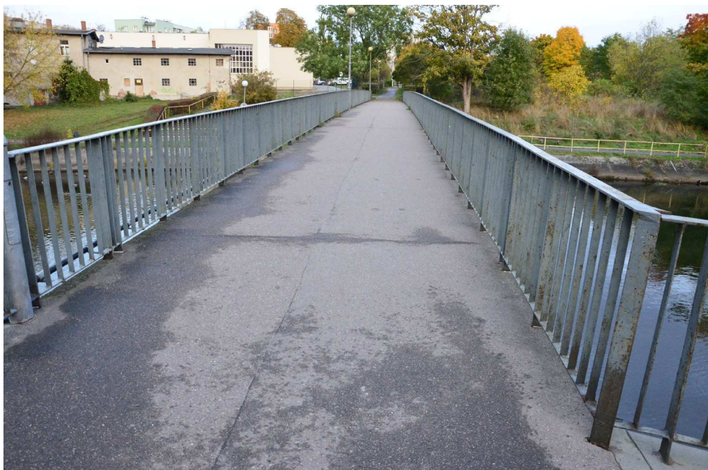
Fot. 2 Widok na chodnik
