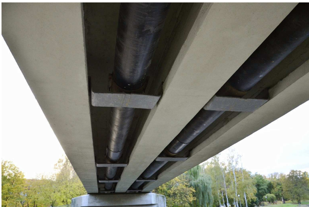
Fot. 3 Widok na spód ustroju nośnego
