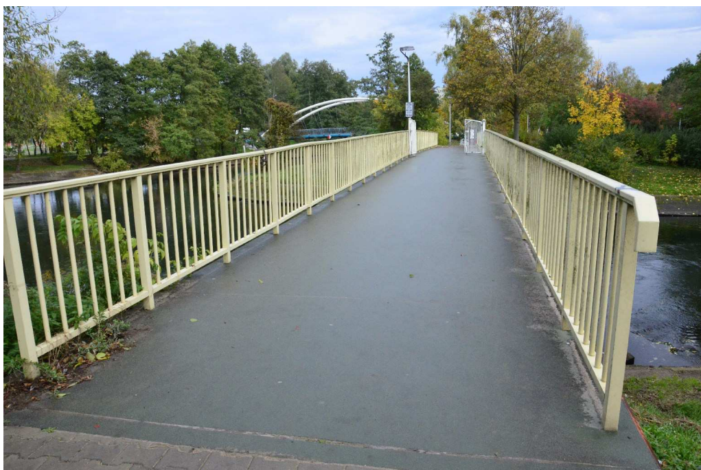
Fot. 2 Widok na chodnik
