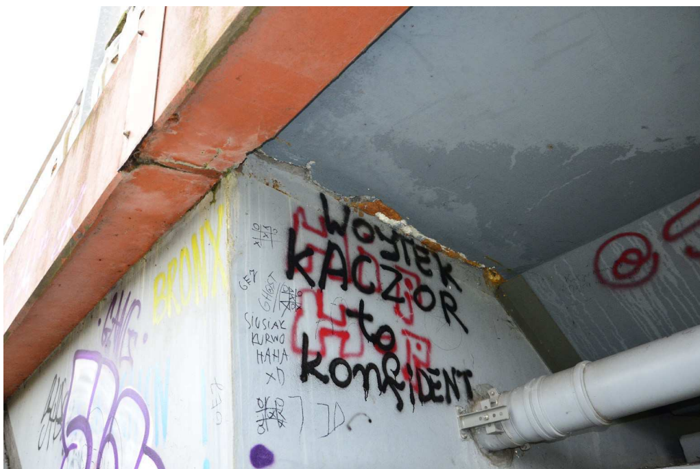
Fot. 13 Wspornik podchodnikowy
