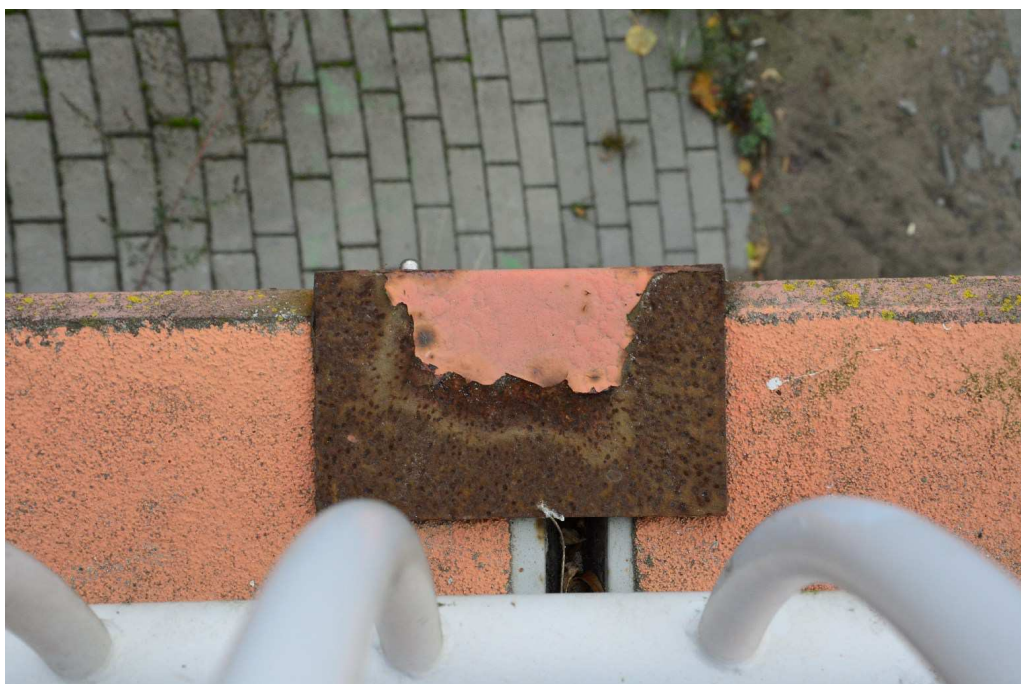
Fot. 10 Urządzenie dylatacyjne
