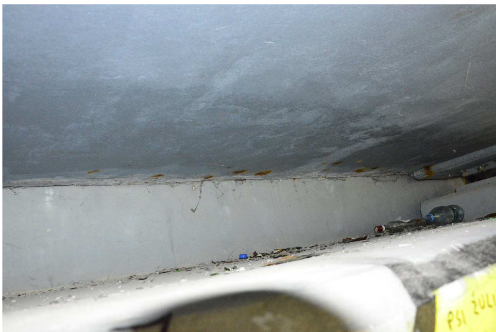
Fot. 14 Krawędź płyty ustroju nośnego
