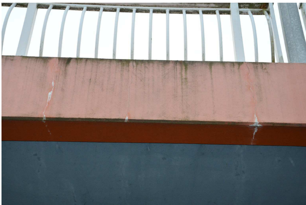
Fot. 11 Belka gzymsowa
