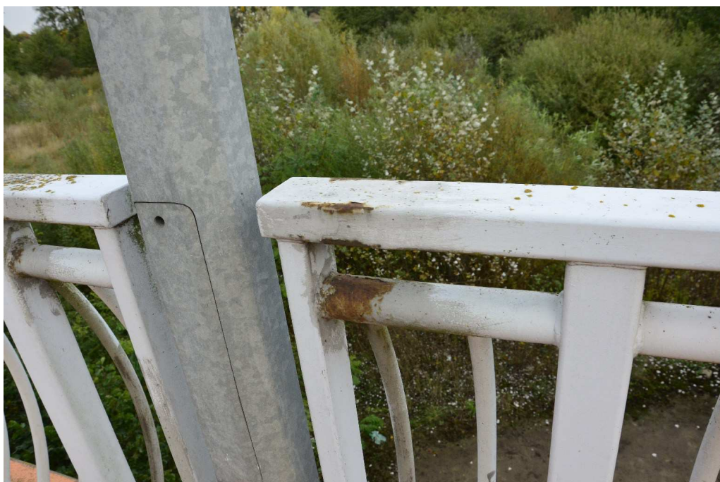
Fot. 9 Balustrada na obiekcie
