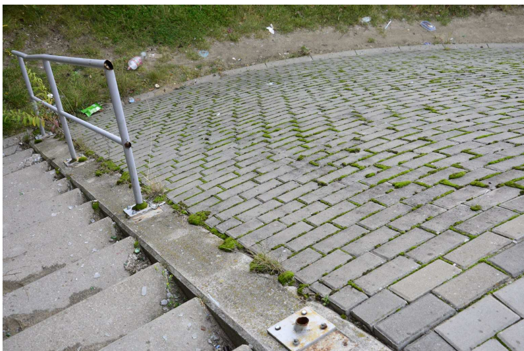
Fot. 20 Balustrada schodów skarpowych
