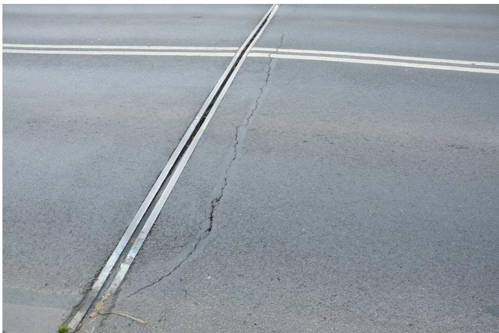
Fot. 3 Nawierzchnia jezdni na dojeździe do obiektu
