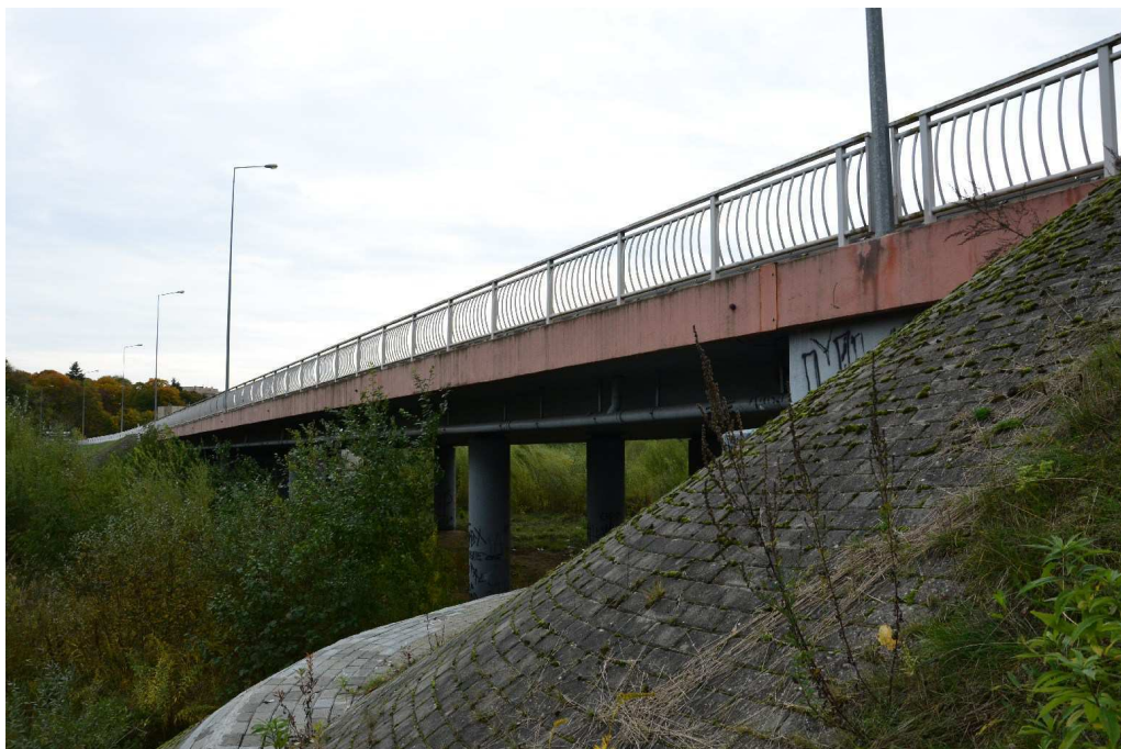
Fot. 2 Widok na jezdnię na obiekcie
