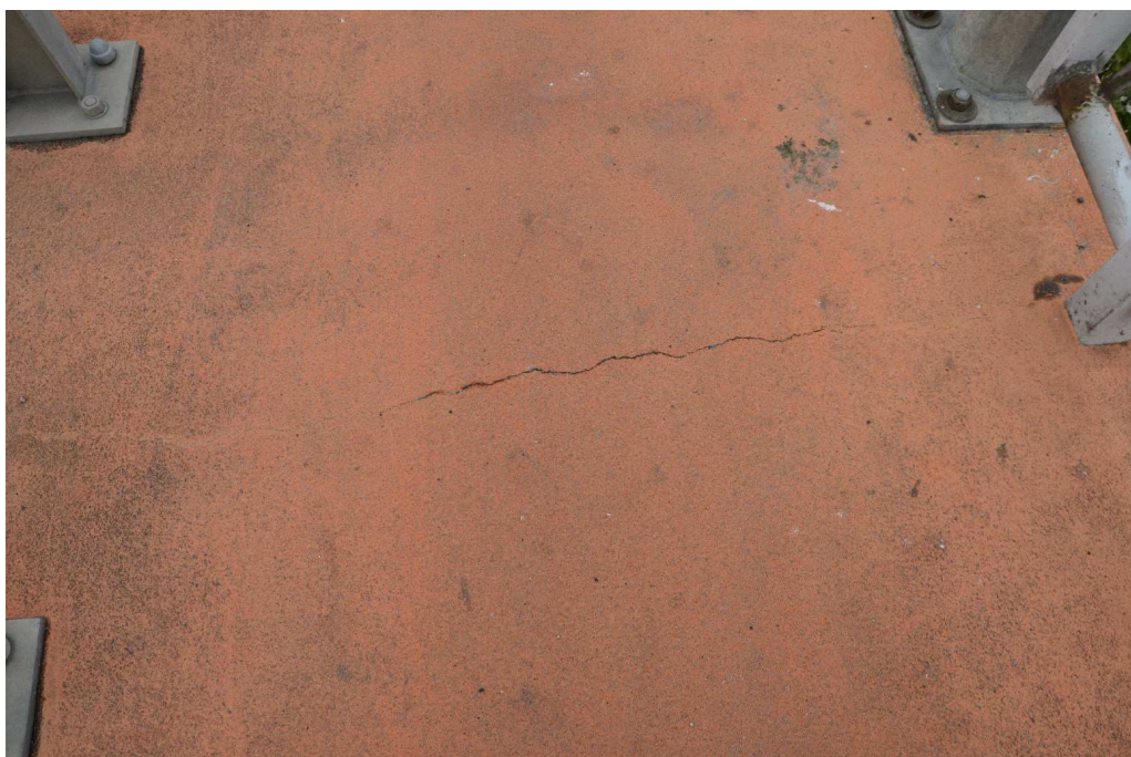
Fot. 8 Nawierzchnia żywiczna chodnika
