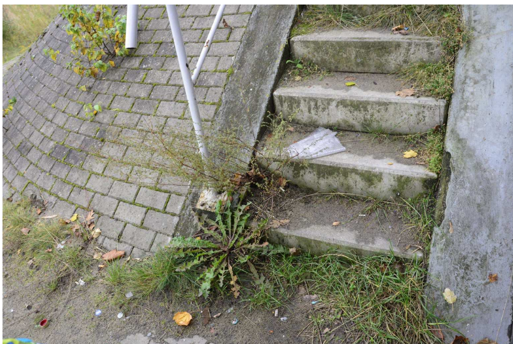
Fot. 19 Schody skarpowe
