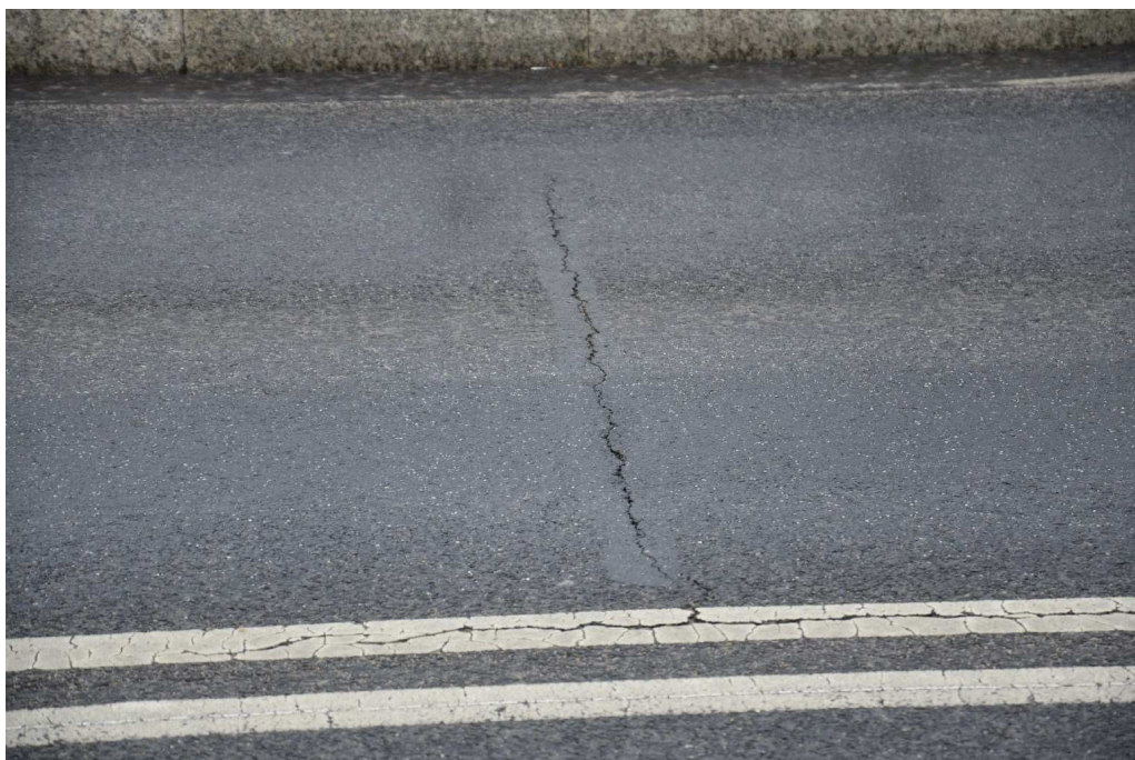
Fot. 4 Nawierzchnia jezdni na obiekcie
